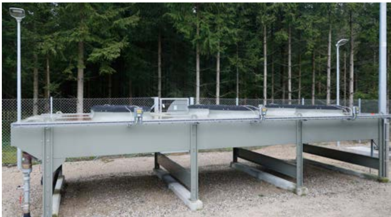
Foto nr. 02. Køler til kompressorer.
